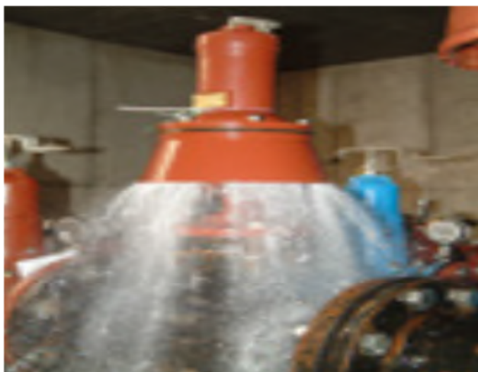
Figure N°V.3 : soupape de décharge
