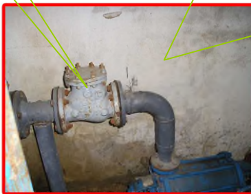
Groupe électro- pompe à axe horizontal
