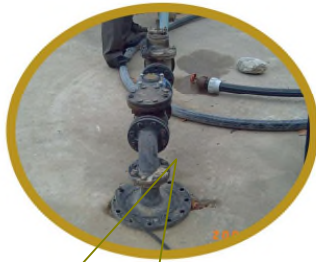
Pompe immergée avec ses accessoires
