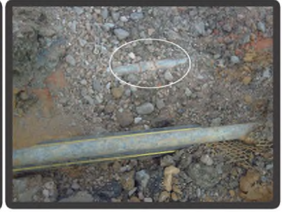
EMPLACEMENT DE LA CONDUITE D'AEP PAR RAPPORT A CELLE DE L'ASSAINISSEMENT
