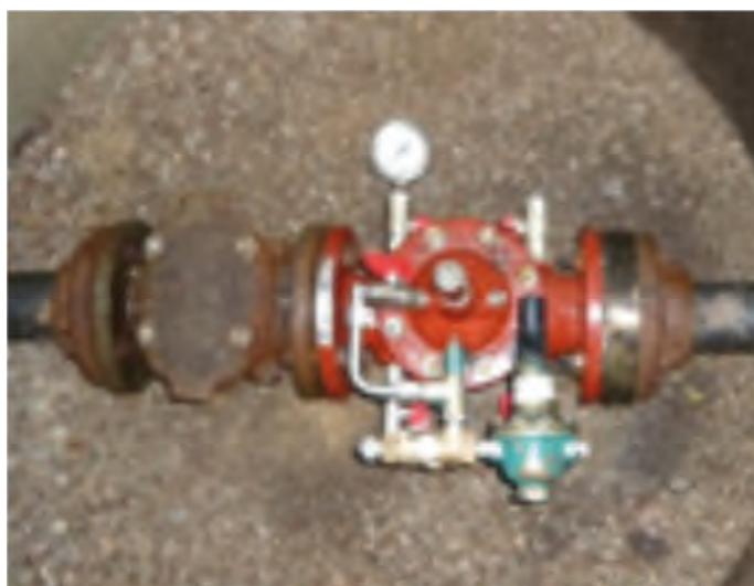
Figure N°V.1 : Vanne stabilisatrice de pression
