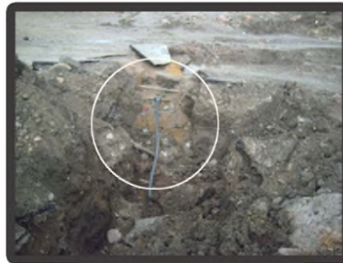
PRESENCE DE DIVERS CONDUITES ET DE DIFFERENTS DIAMETRES
