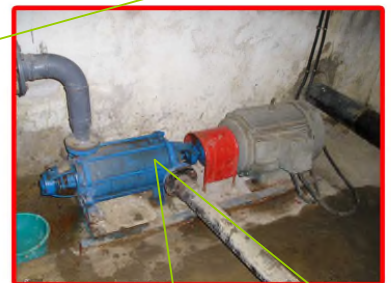
Groupe électro- pompe à axe horizontal
