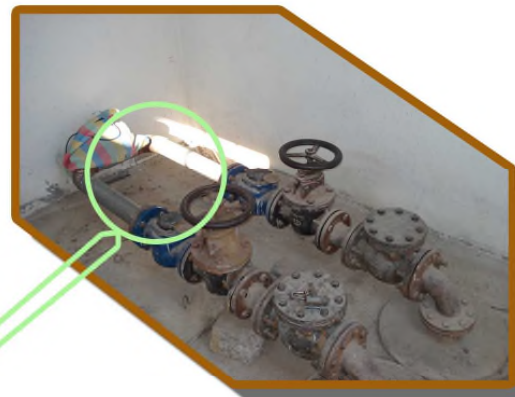
Conduite de départ divergente de φ 102/114 au φ 150 AE
