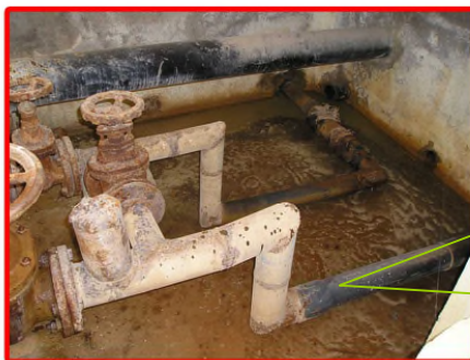
Conduite d'arrivée \phi 150
