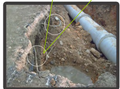
EMPLACEMENT DE LA CONDUITE D'AEP PAR RAPPORT A CELLE DE L'ASSAINISSEMENT
