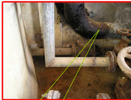
Conduite d'arrivée \phi 150
