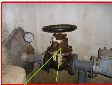
Vanne de sectionnement défectueuse + manomètre
