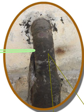
Conduite de départ divergente de φ 102/114 au φ 150 AE
