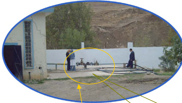
Dalle de La Bâche 200m 3 enterrée
