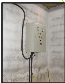
Disjoncteur différentiel avec DRT pour la pompe de refoulement à la mechta BEN ZEKRI
