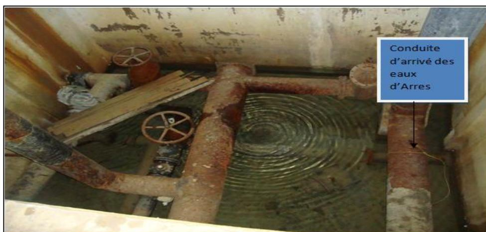
Figure VI.5. Conduite d'arrivée des eaux des forages d'Arres (Réservoir Kharba Supérieur).
