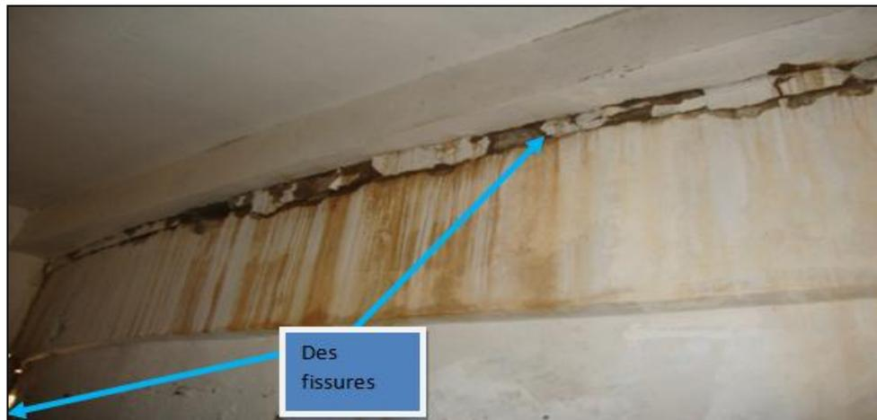
**Figure VI.6.** Différentes fissures sur le mur extérieur du réservoir Kharba supérieur.
