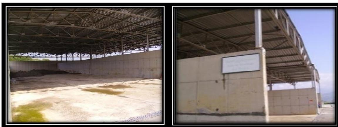
**Figure N°40**: Aire de stockage des boues sèches.
