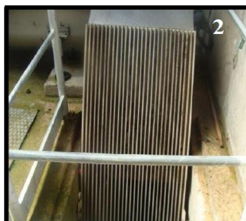
**Figure N°27: Dégrilleur fin (1 : automatique, 2 : manuel)**
