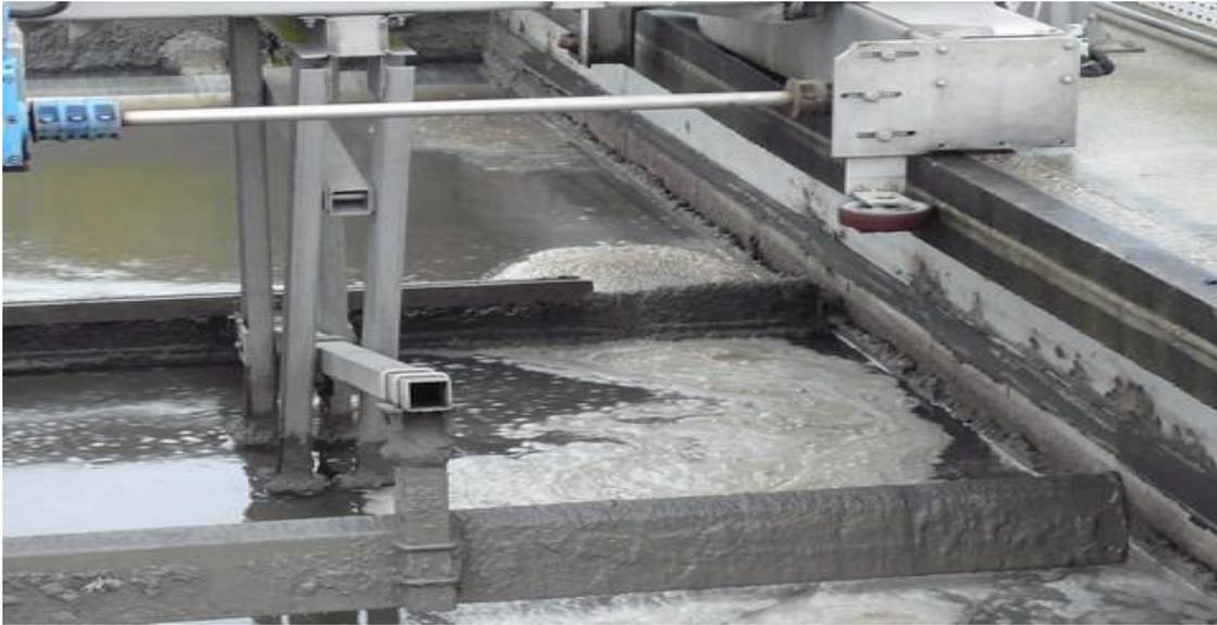
**Figure N°14** : Photo d'un déshuileur utilisé dans l'épuration des eaux usées
