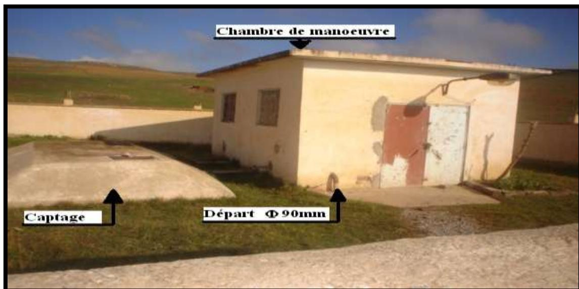
**Figure(II.1) :** Aménagement actuel de la source (Mûr de clôture- chambre de manœuvre – captage).
