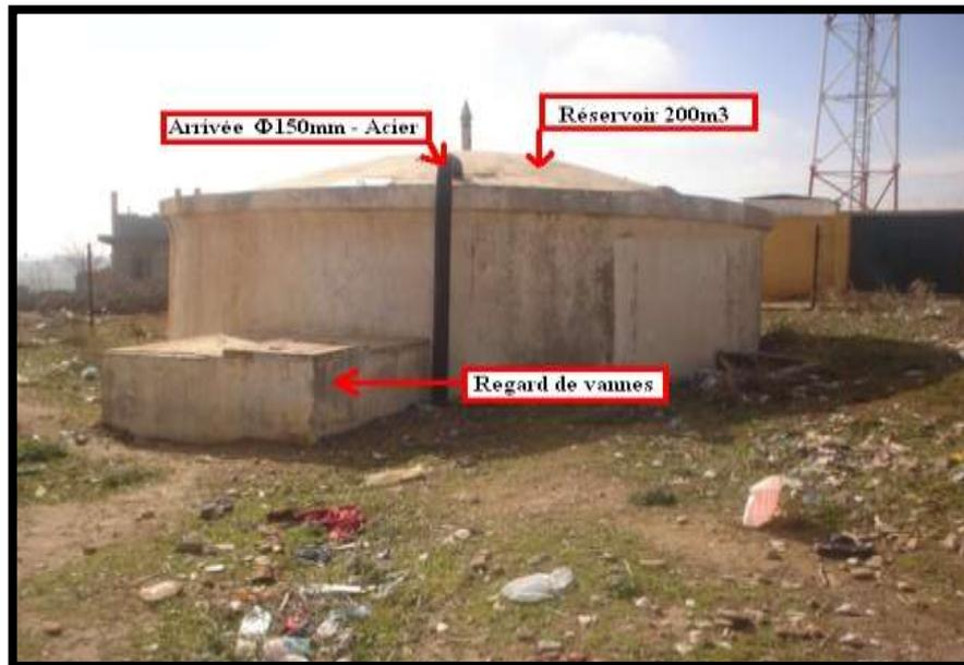
Figure(II.11) : Réservoir semi enterré 200m<sup>3</sup>.
