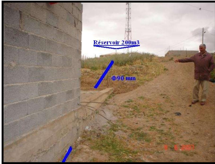
Figure(II.15) : Habitation construite sur la conduite d'adduction captage – réservoir 200m<sup>3</sup>.
