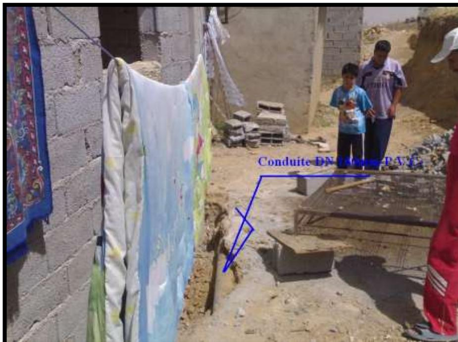
**Figure(II.18)** : Construction réalisée au dessus de la conduite en P.V.C  $\Phi 160\text{mm}$ .
