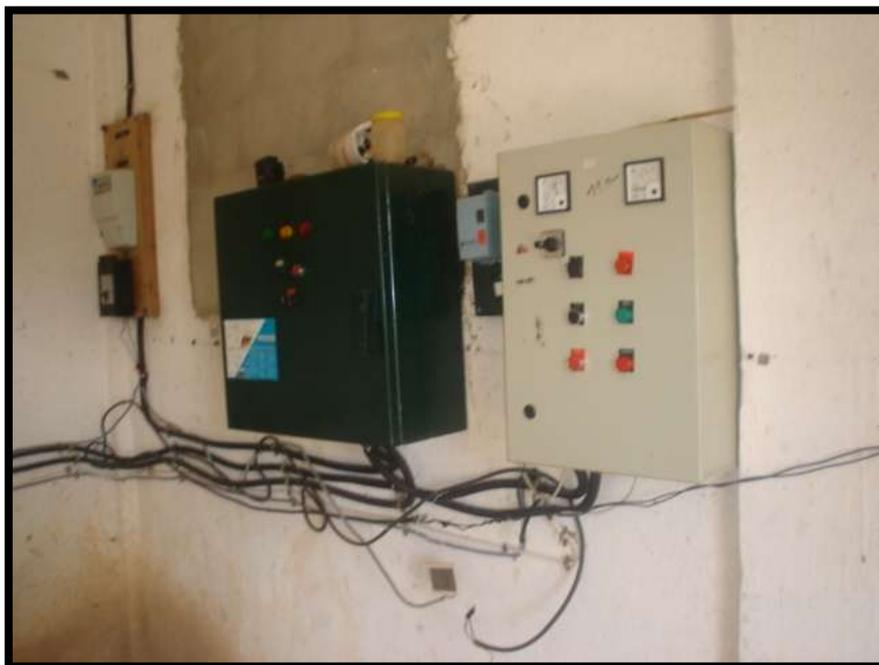
**Figure(II.5) : Armoire de commande.**
