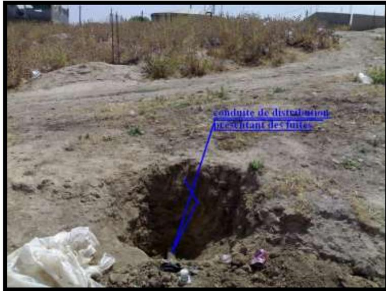
**Figure(II.19)** : Le sondage démontre l'état de vétusté de la conduite de distribution (présence de fuites).
