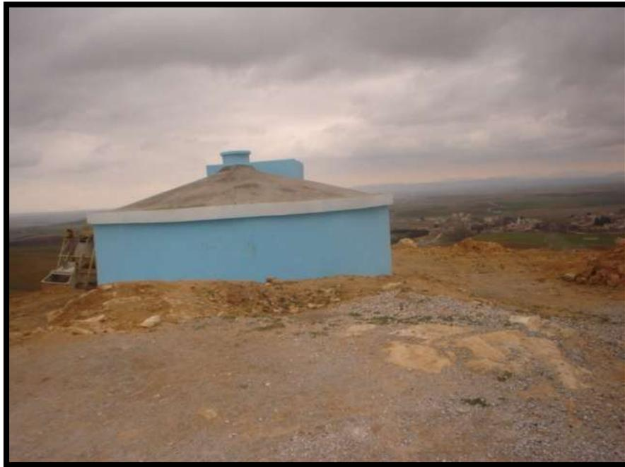
**Figure(II.13)** : Le nouveau réservoir semi enterré 250m<sup>3</sup> réalisé en 2006.
