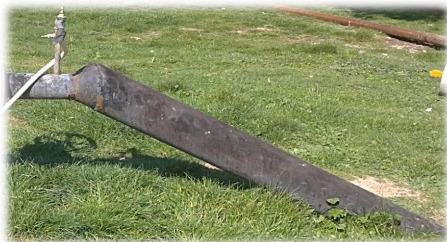
Figure 18 : Conduite de refoulement du forage Ain Beida (DN250 en fonte).
