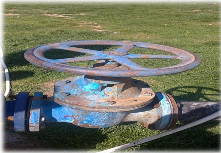
**Figure 15 :** Robinet vanne DN 100 PN16 en fonte
