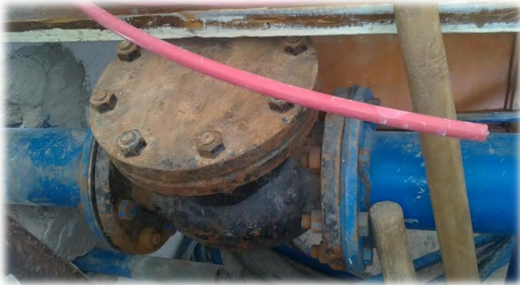
**Figure 5 :** Clapet anti retour
