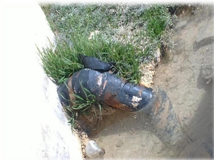
Figure 27 : Fuites à l'extérieur du réservoir 300m<sup>3</sup>.
