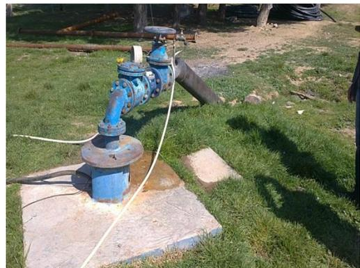
HARCHA: Le forage HARCHA est équipé avec une pompe immergée, dans le débit de refoulement est de 18L/s avec une hauteur manométrique totale (HMT) de 173m. Elle est calée à une cote de 120m.<sup>[2]</sup>
