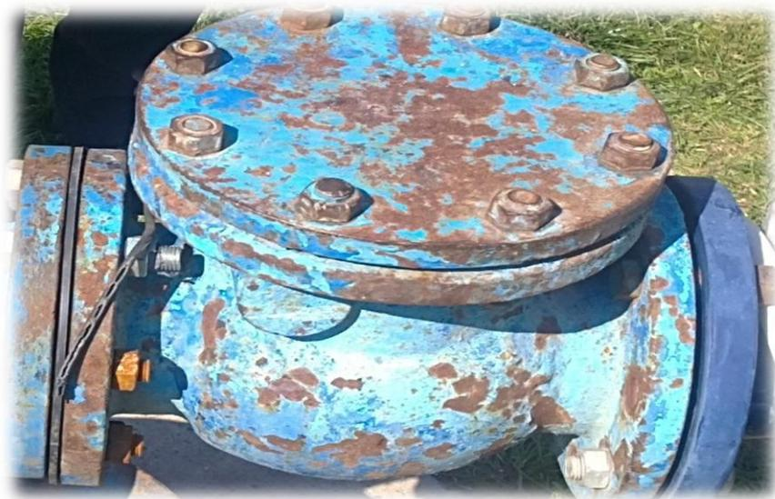
**Figure 16 :** Clapet anti retour DN 100 PN16 en fonte
