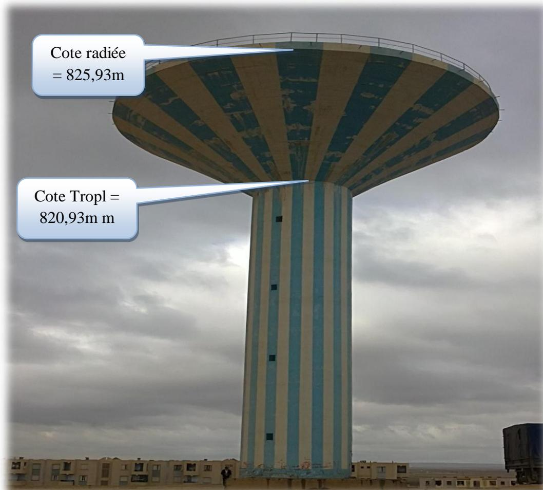
Figure 20 : Réservoir 1000 m<sup>3</sup>.
