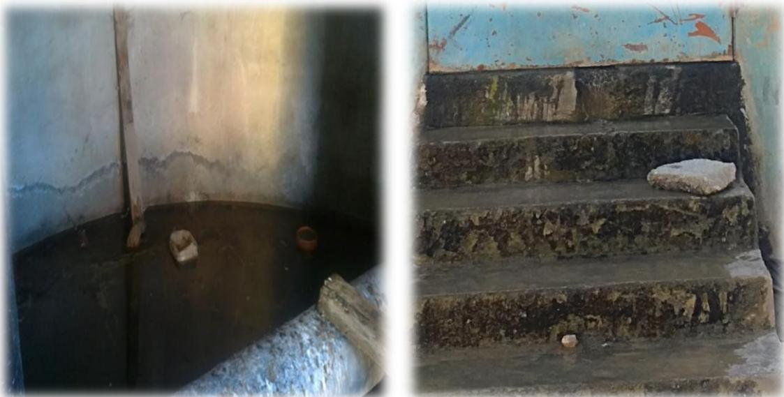
Figure 23 : Fuites à l'intérieur et à l'extérieur du réservoir
