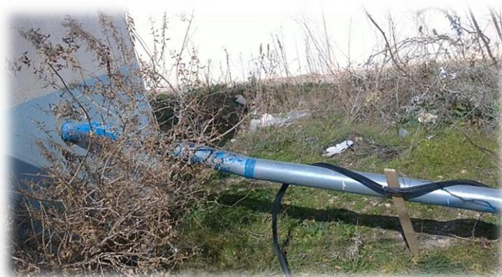
Figure 11 : Conduite de refoulement (DN200) vers le réservoir 1000m<sup>3</sup>.
