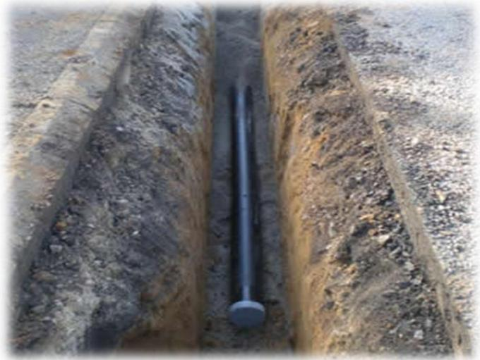
**Figure 4:** Pose des canalisations
