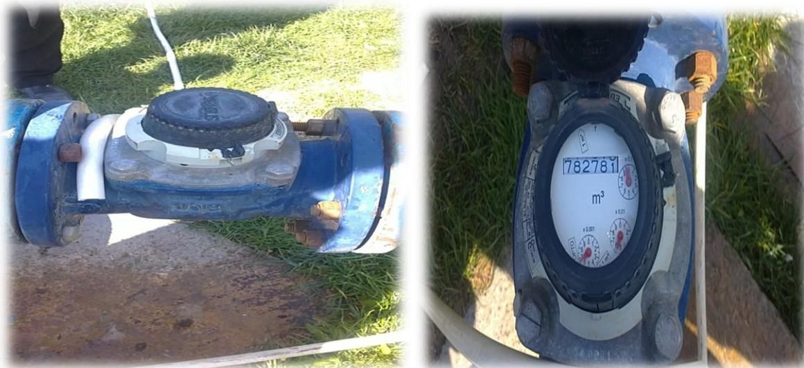
Figure 17 : Compteur DN100mm
