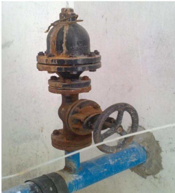
**Figure 6 :** Ventouse(DN100mm) en fonte
