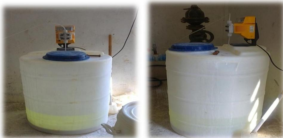
Figure 9 : Le réservoir d'eau javel.
