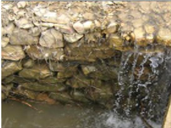
**Figure(2.10) :** Seuils de sédimentation en Gabions et en pierres sèches réalisées dans le bassin Versant du barrage BAKHADDA
