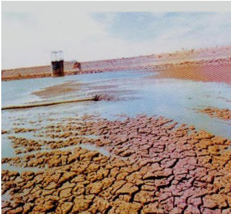
**Figure (2.1):** Envasement du barrage de BAKHADDA TIARET (2008)
