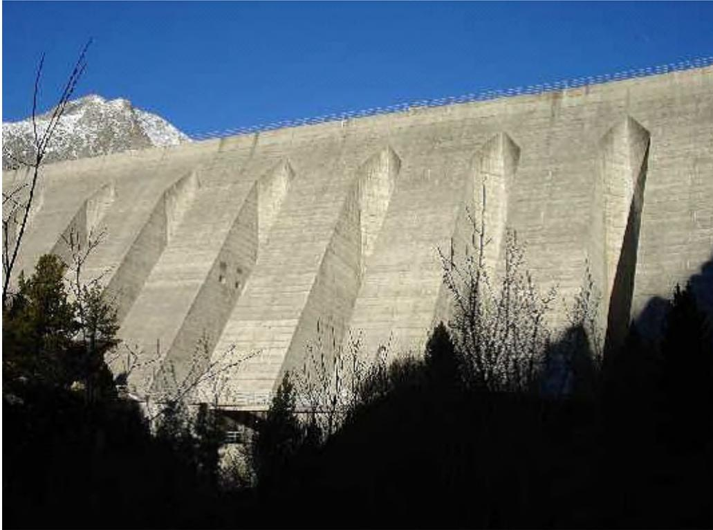
**Figure (1.2) :** Barrage poids à contreforts de Plan d'Amont (Aussois).
