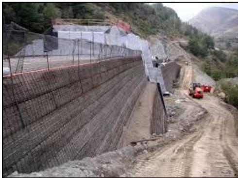
**Figure.5 :** Mur en gabion.
