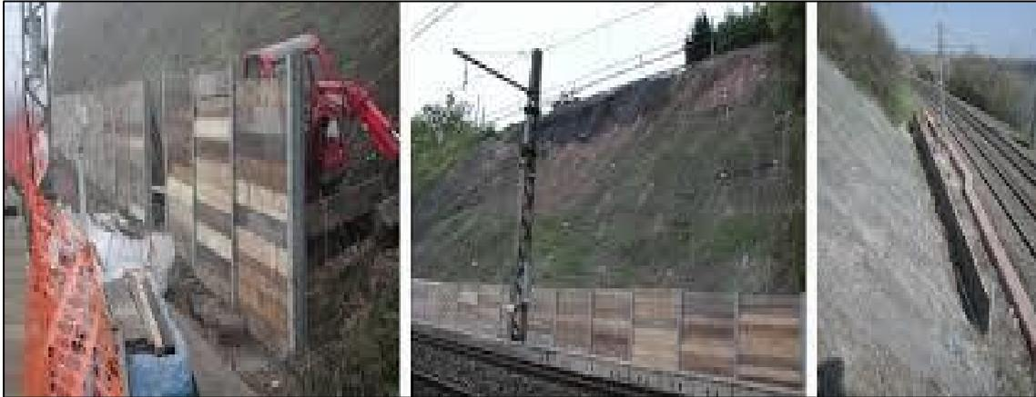
**Figure .4:** Renforcement par Mur en plaque.
