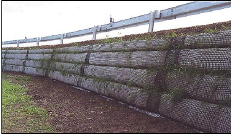
**Figure16** : *Renforcement par inclusion géo synthétique.*
