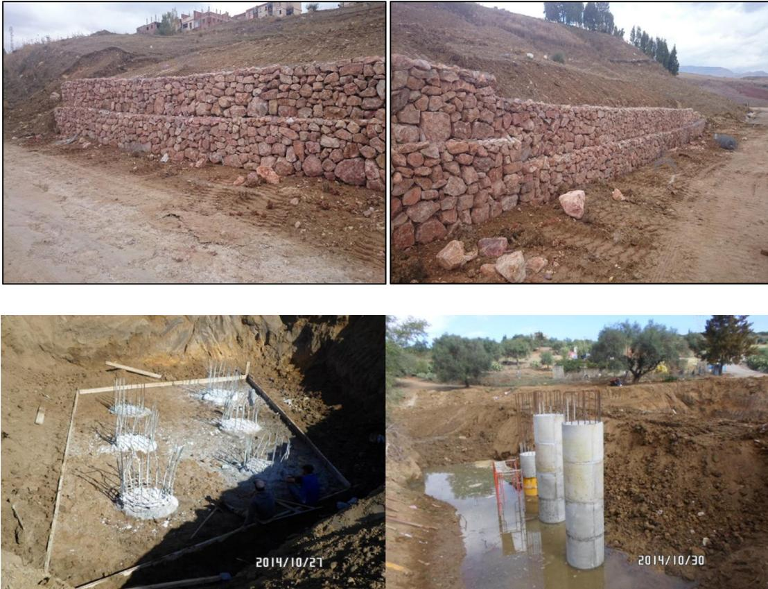
**Figure 30 :** *Renforcement par les murs proposés et les pieux.*
