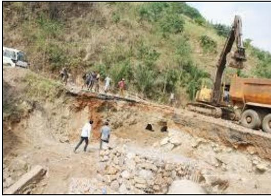
**Figure.9 :** *Mur en gabion.*
