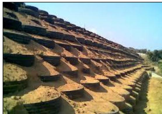
**Figure.8 :** Mu en pneu sol.
