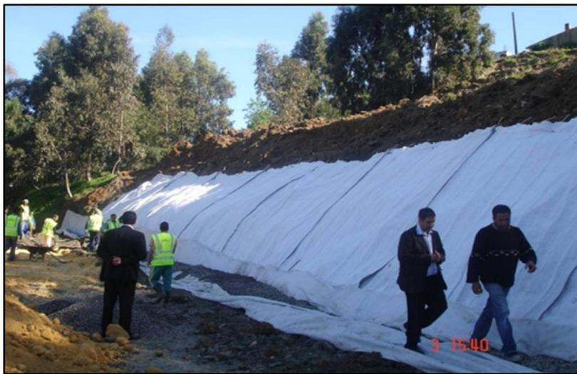
**Figure. 10.** *Mise en œuvre du géocomposite de drainage équipé de mini-drains.*
