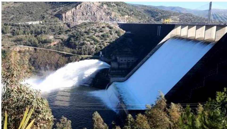
Figure III.1 : Évacuateur de crues de Barrage Béni Haroun.
