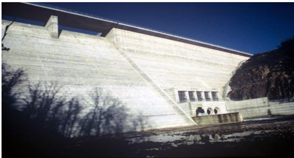
Figure II.1 : Barrage de La Touche Poupard (France)
