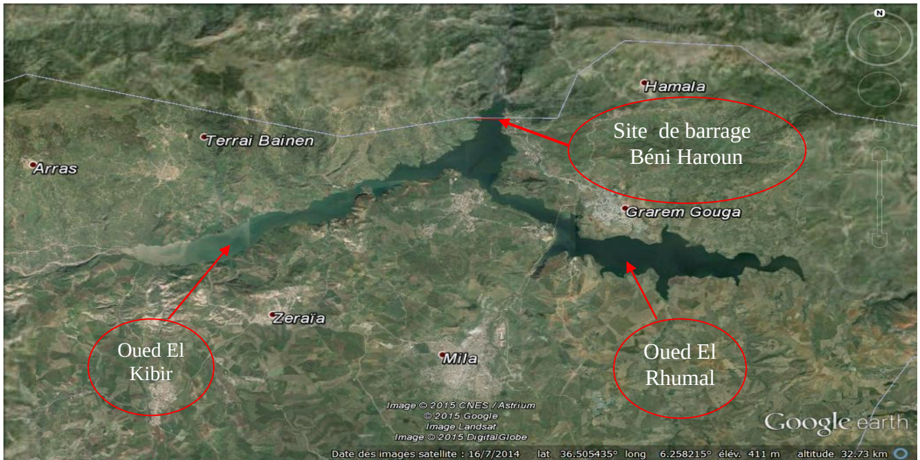
Figure I.3 : Site du barrage Béni-Haroun
