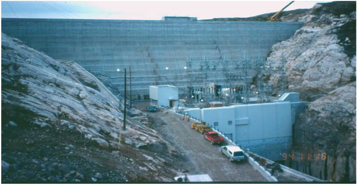
Figure II.2 : Le barrage du Lac Robertson (Canada) .
