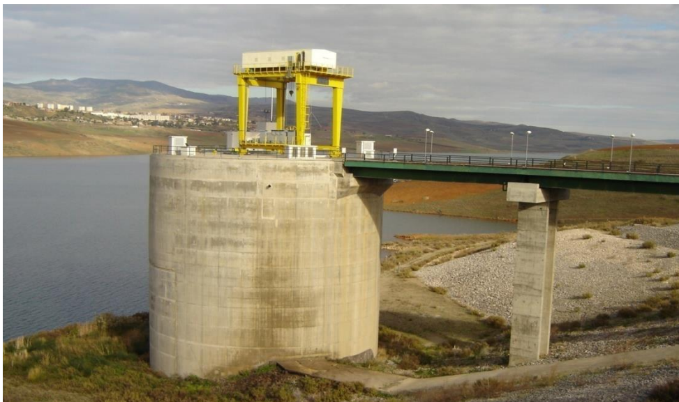
Figure III.6 : Bâtiment des pompes de Barrage Béni Haroun
