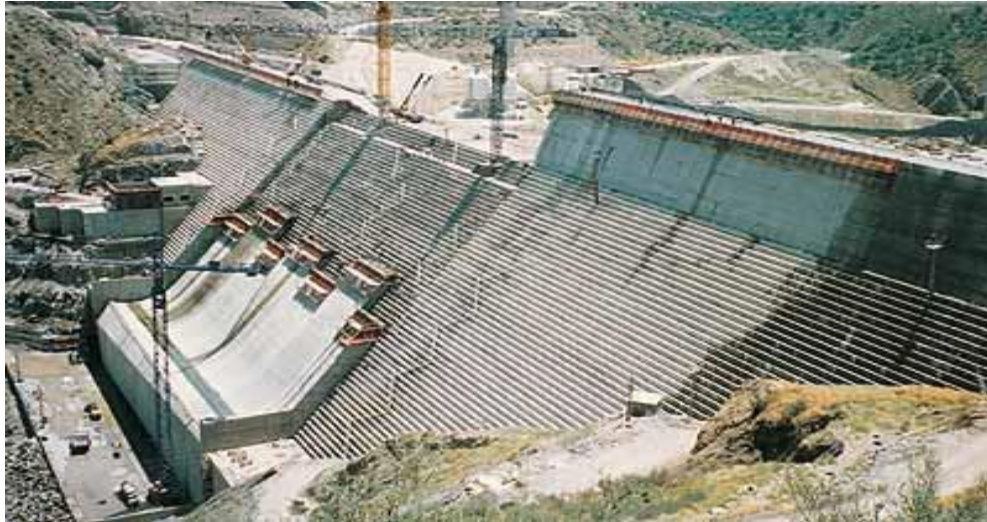
Figure II.4: Barrage Béni Haroun en cours de réalisation (année 2000).
