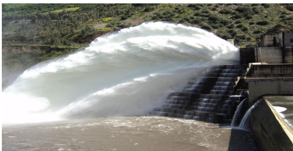
Figure III.4 : Vidange de demi-fond de Barrage de Béni Haroun.
