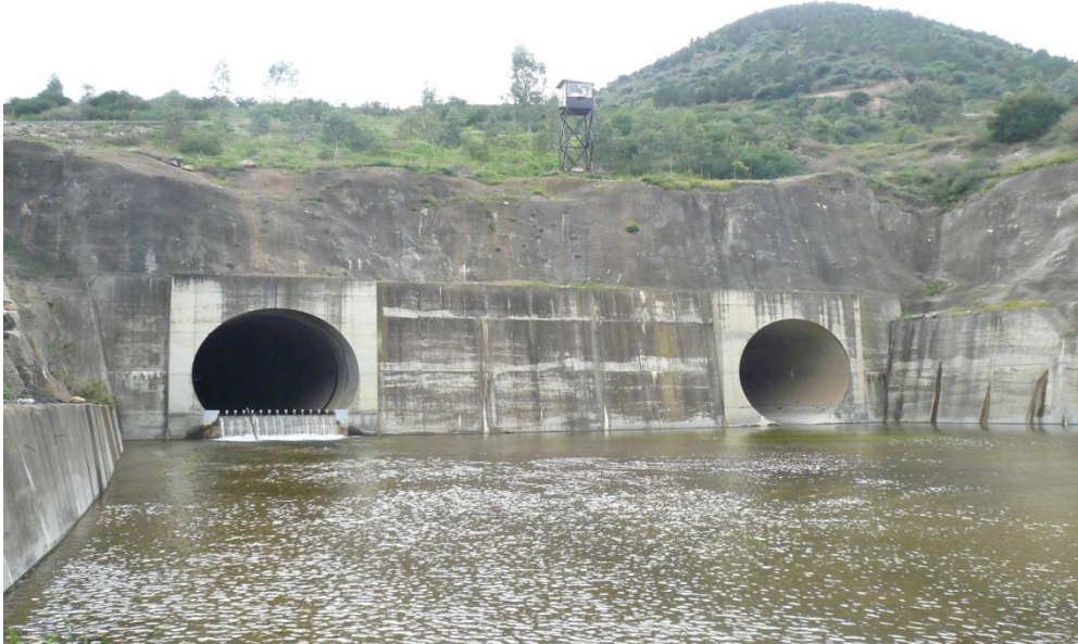
Figure III.3 : Galeries de dérivation de Barrage Béni Haroun.
