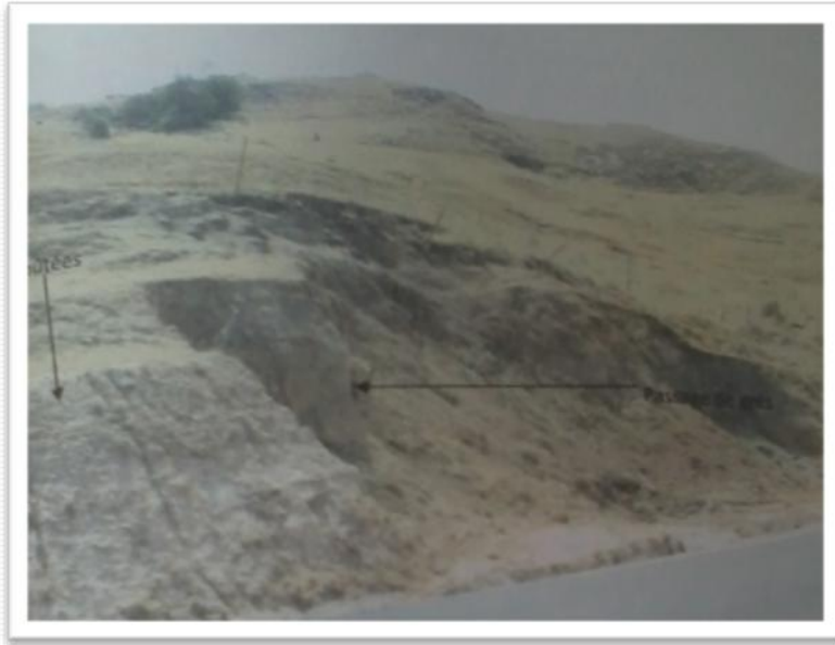
Figure. III.10 Marne encroutées stable avec des passages de grés cimentés
