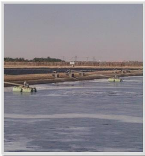
Lagune d'aération et lits de séchage
