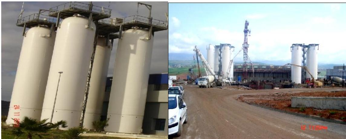
*Fig.10 : Ouvrages Anti-Beliet installés à la station de Beni Haroun .*
