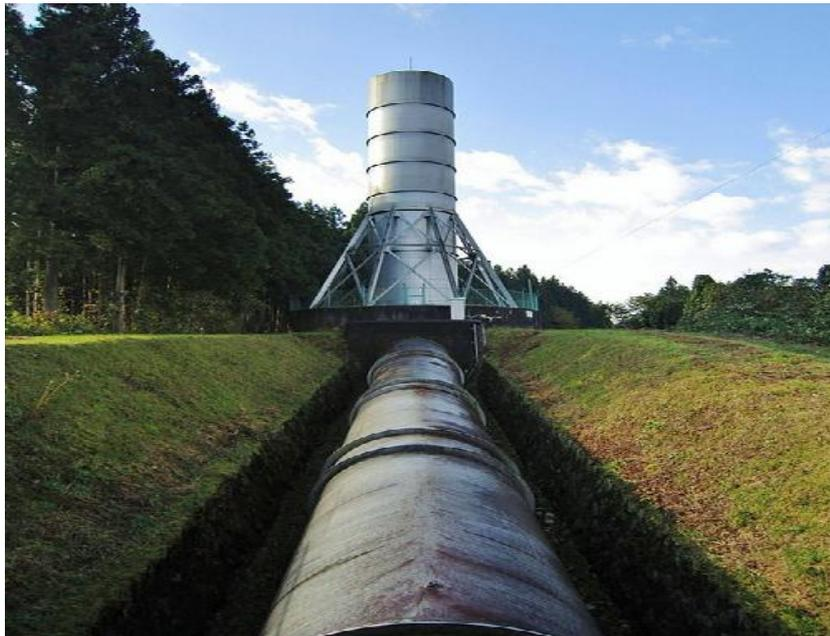
*Fig.12 : Exemple d'une cheminée d'équilibre installée sur un réseau forcé*
