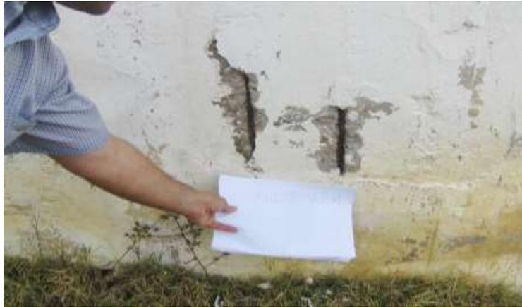
**Fig.I.31 : absence d'enrobage des aciers verticaux du réservoir**
