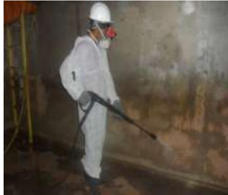
**Fig.I.24 : rinçage de réservoir**
