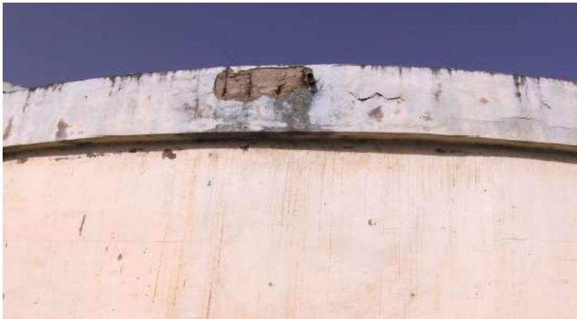
**Fig.I.32 : gonflement au niveau de la ceinture supérieur du réservoir**
