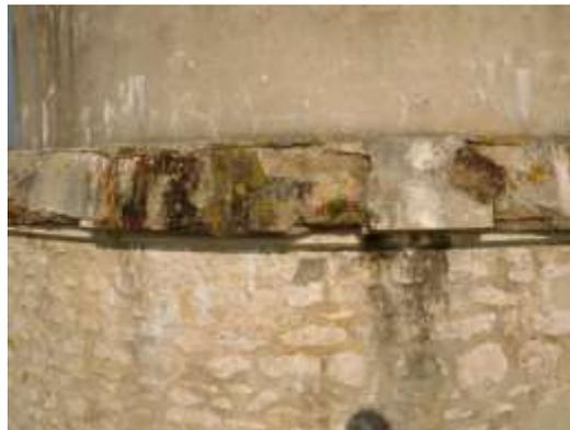
**Fig.I.29 : éclat et dégradations sur la ceinture basse**
