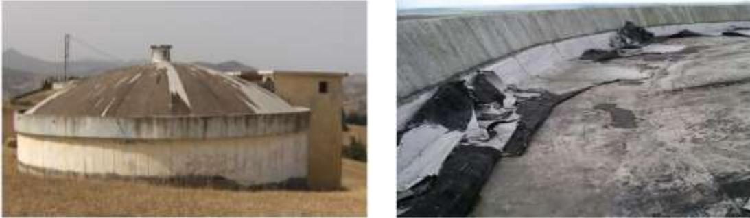
**Fig.I.30 : couverture dégradée**
