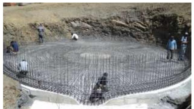
**Fig.II.6 : ferrailage vertical de la paroi**
