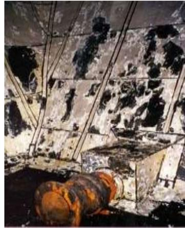
**Fig.I.28 : Les dégradations de revêtements**
