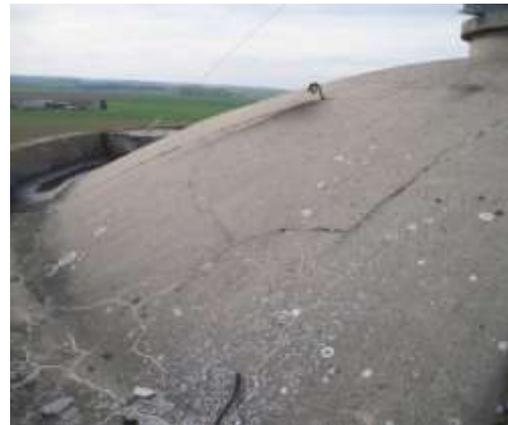
**Fig.I.27 : fissuration de l'enduite sur coupole**
