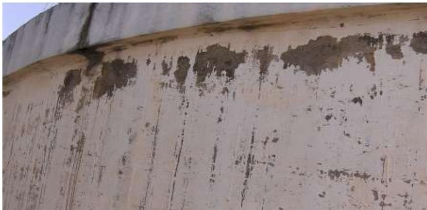
**Fig.I.30 : écaillage sous la ceinture supérieur du réservoir****I.10.6-Défaut d'enrobage des armatures :**
