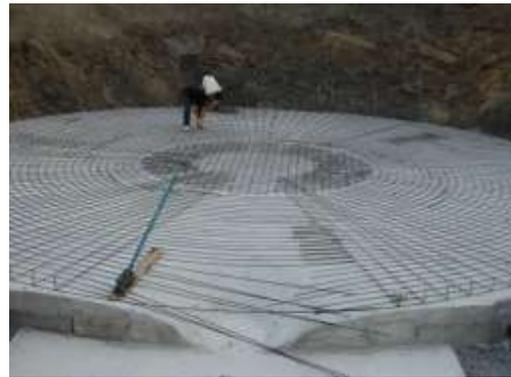
**Fig.II.4 : ferrailage de radier**
