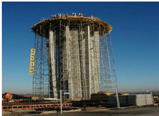
Figure 18 : mise en place de l'échafaudage
