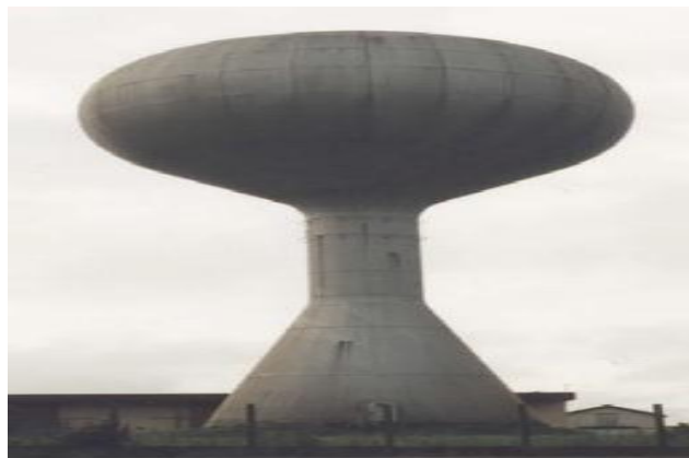
Figure10 : Réservoir sphéroïdale
