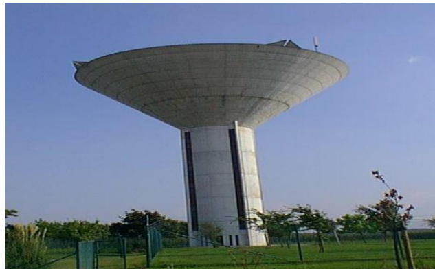
Figure 8 : Réservoir construit en 1985 -1600m 3
