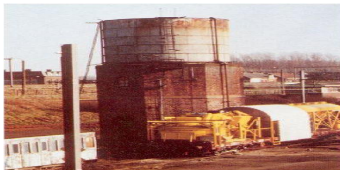
Figure 2 : Réservoir métallique sur fût maçonné du début du XXe siècle
