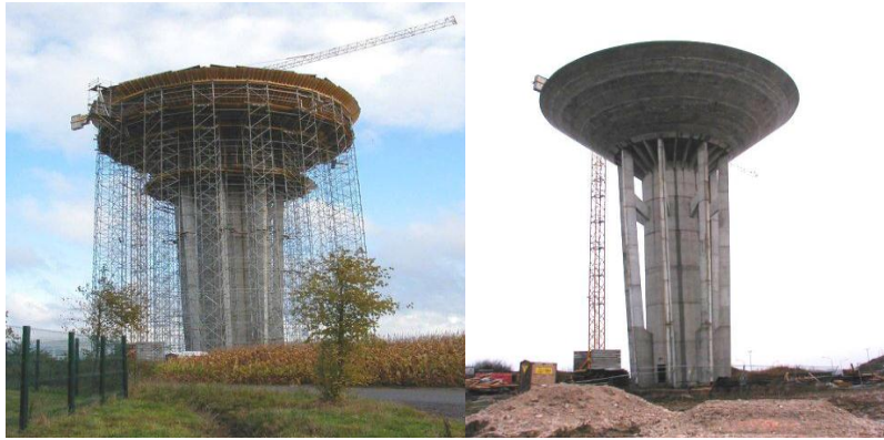
Figure 17 : Réalisation de la cuve
