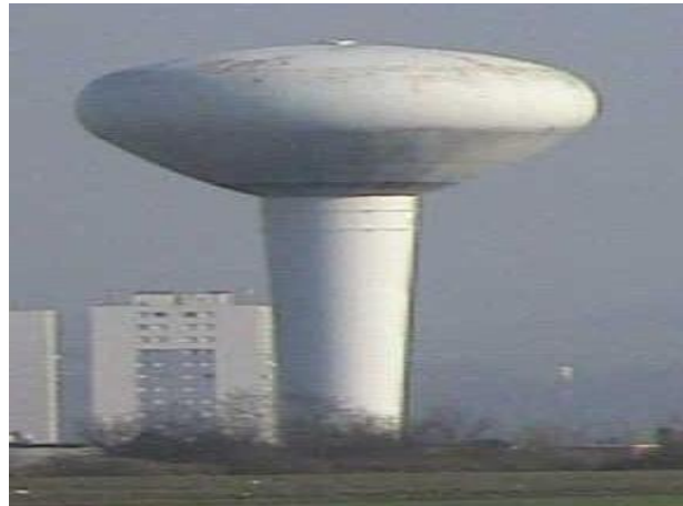
Figure11 : Réservoir à fond sphéroïdale
