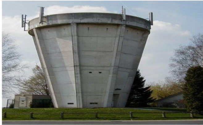
Figure 7 : Réservoir construit en 1977 –200 m 3
