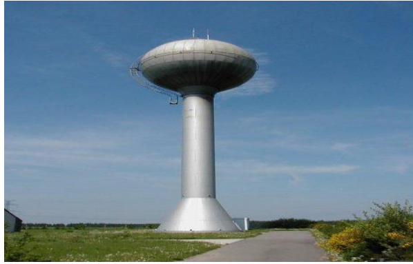
Figure9 : Réservoir construit en 1976 –1000 m 3
