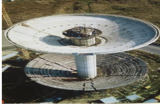
Figure 19 : Levée de la cuve par câbles
