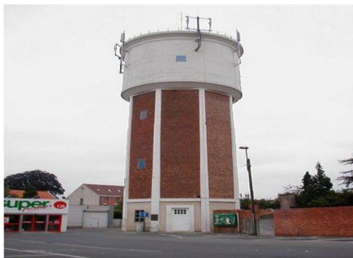
Figure6 : Réservoir construit en béton 1930 – 500 m 3
