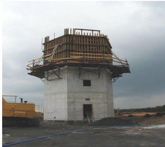
Figure 16. Coffrage grimpant du fût
