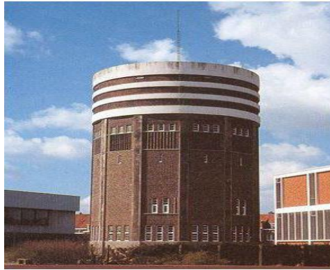
Figure 5 : Réservoir construit en 1936 – 700 m 3
