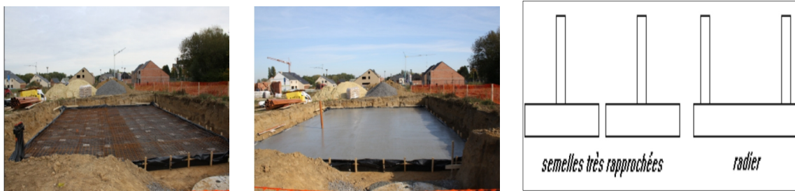
Fig. I.6.Radier générale en béton.
