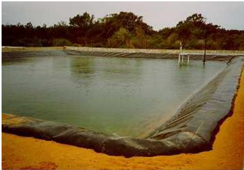
Fig. I.4 : Etang solaire en Libye de 600 m 2 produisant 5 m 3 d'eau douce par jour
