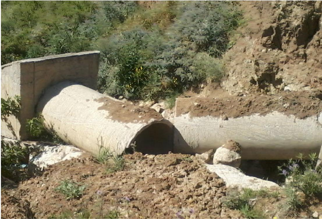
**Figure 17 : Exemple de l'impact du glissement sur l'état du réseau d'assainissement de la ville de Mila**
