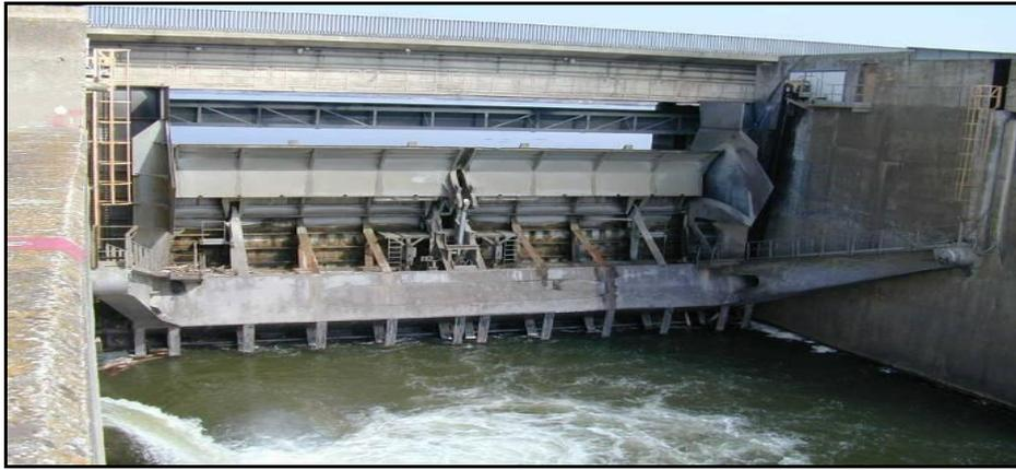
**Figure I.11 :** Vanne segment munie d'un volet de surface(CFBR).
