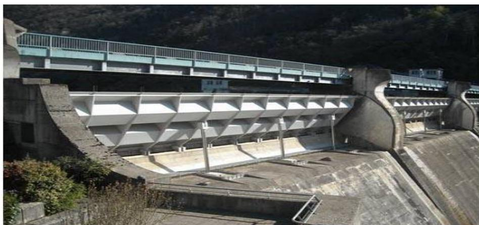
**Figure I.8 :** Clapet sur le barrage(CFBR).
