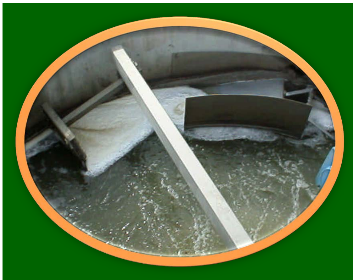
Figure 18 : Racleur des graisses d'un dessableur- dégraisseur
