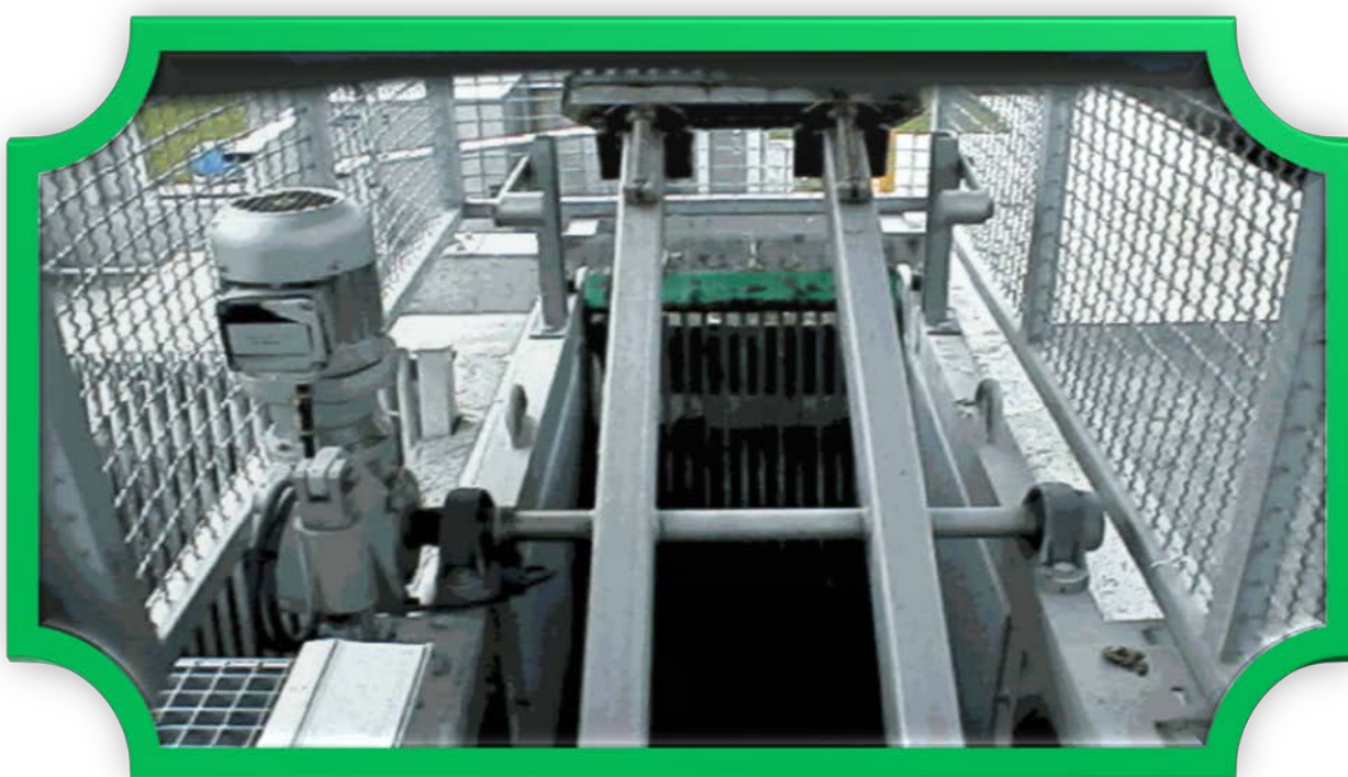
Figure 16 : Dégrilleur courbé [49]
