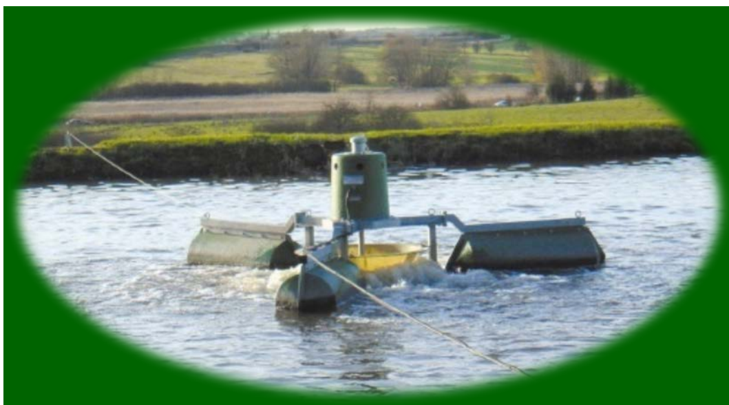
Figure 26 : Vue de l'aérateur Centrox d'une puissance de 5,5 kW [69]
