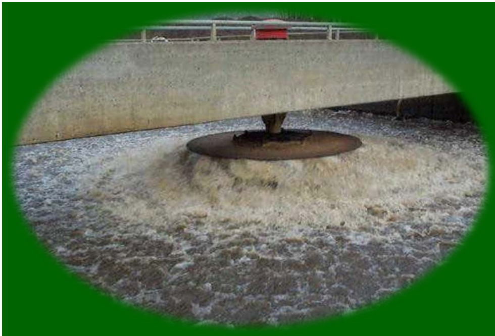
Figure 25 : Turbine de surface à vitesse lente (immersion insuffisante) [49]
