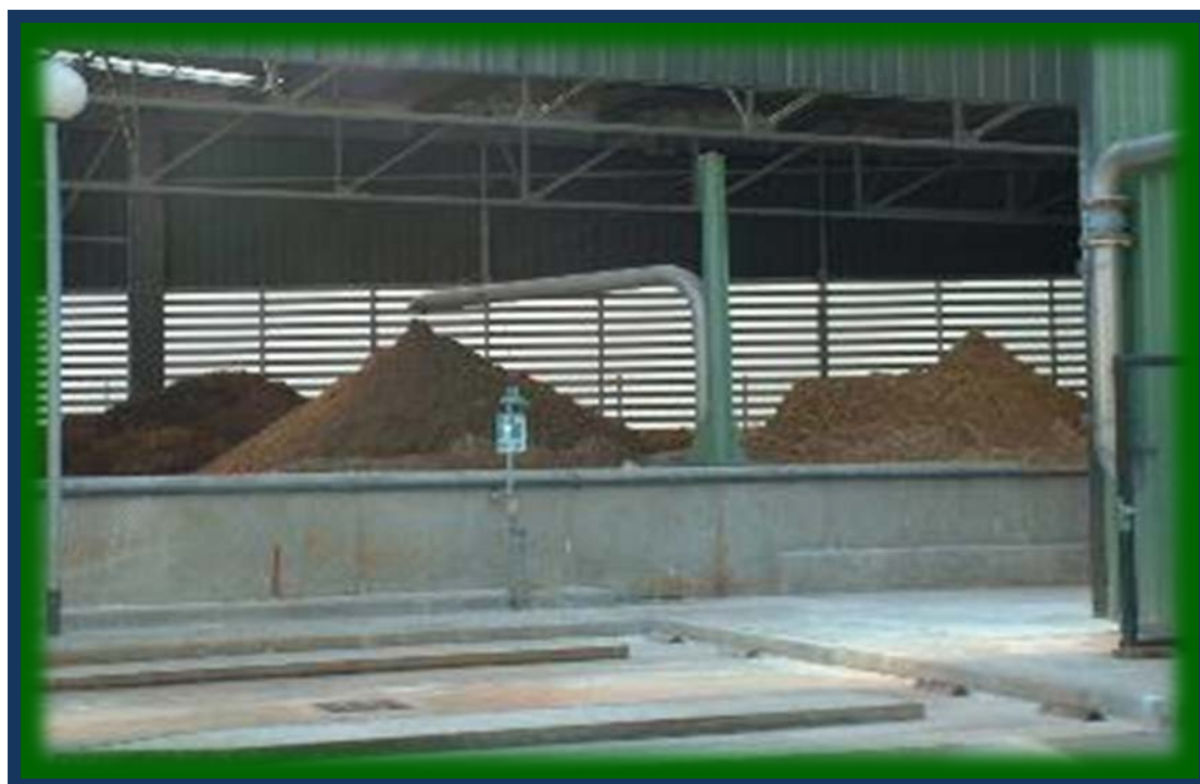
Figure 28: Aire de stockage de boues
