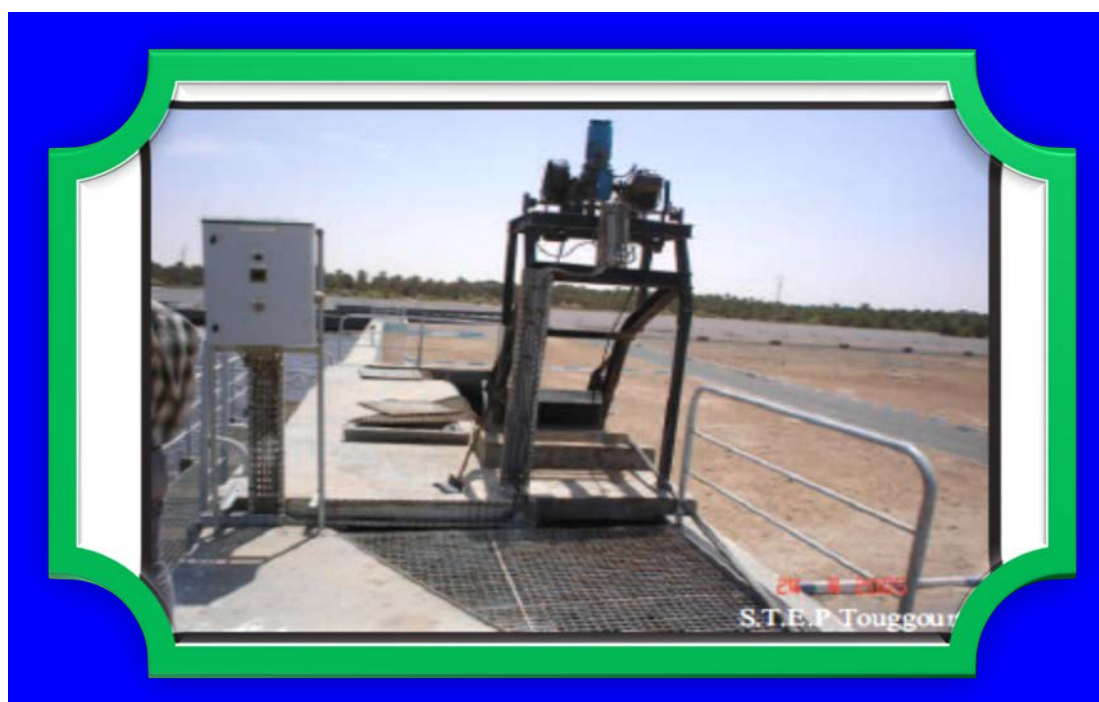
Figure 15: Dégrilleur mécanique [53]
