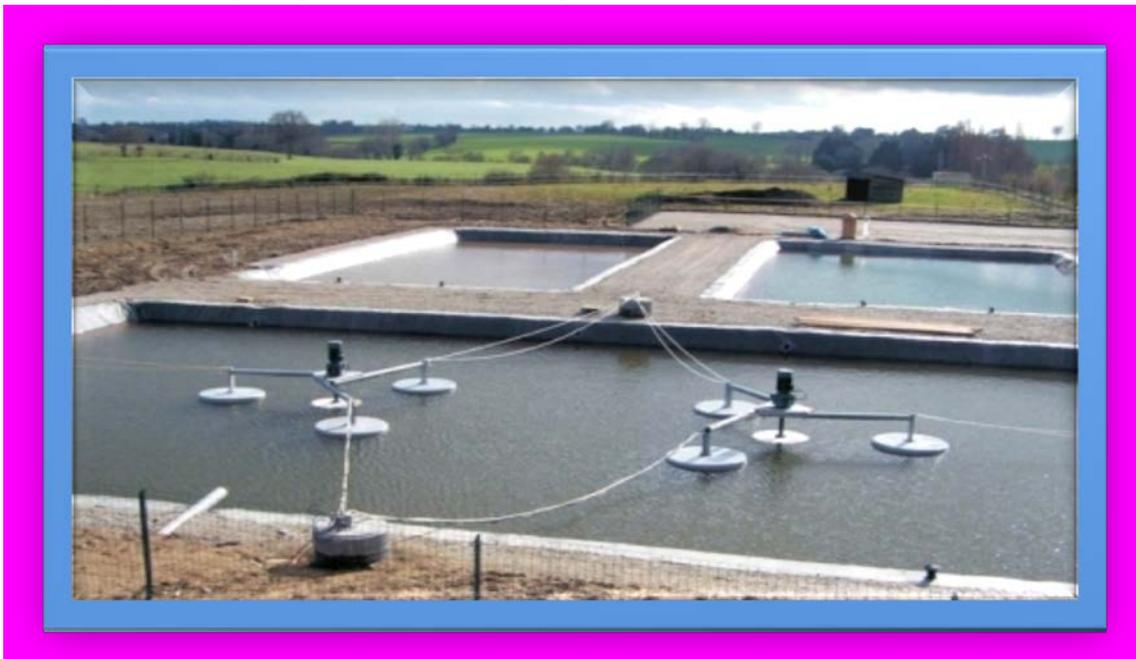
**Photo 12 : Schéma général de lagunage aéré.**
