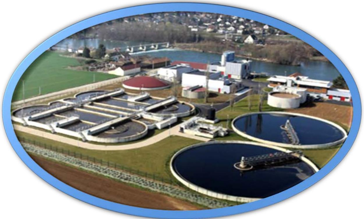
**Photo 09 : Exemple d'une station par boues activées**
