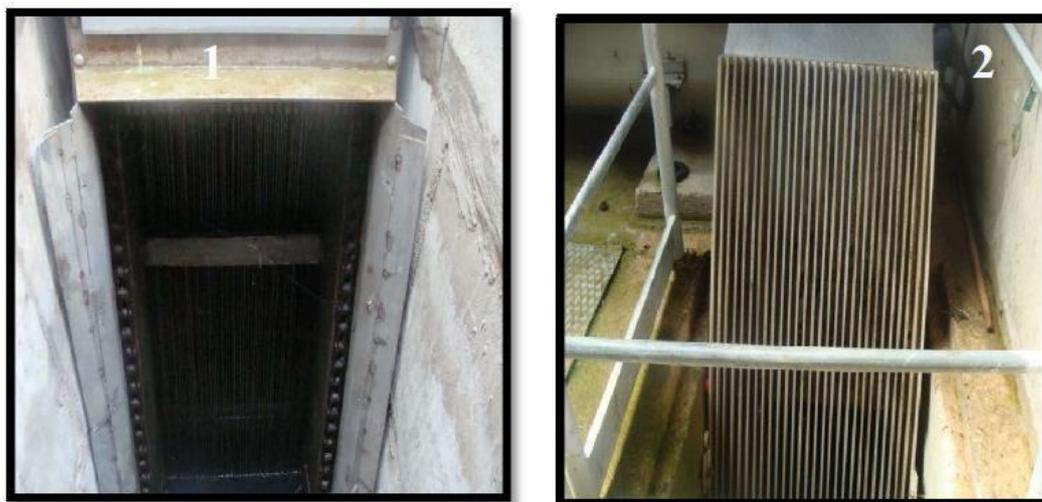
Photo V.2: Dégrilleur fin (1 : automatique, 2 : manuel)
