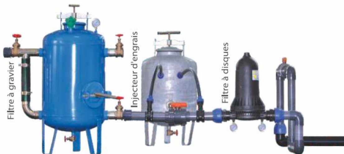
Figure V.3 : Installation de tête .
