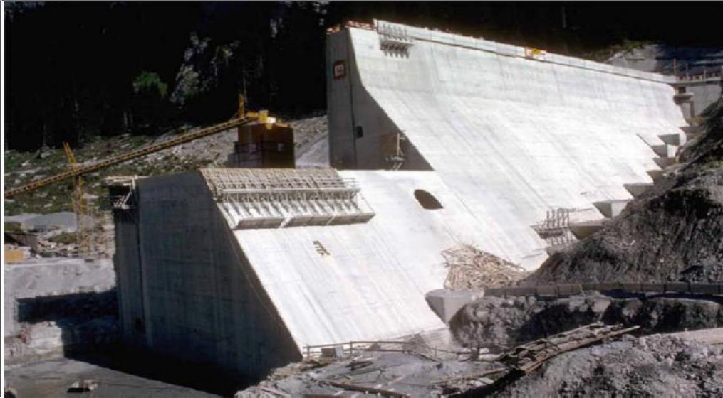
Figure N°06 : Barrage poids.
