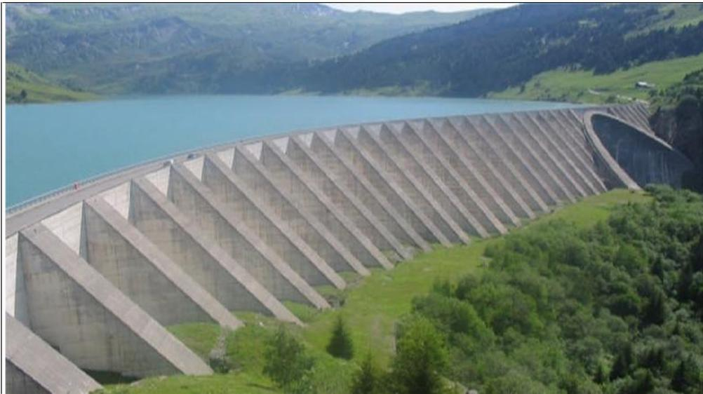
**Figure N°08 : Barrage de contrefort.**
