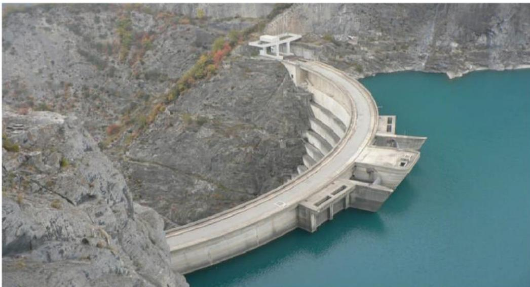
Figure N°07 : Le barrage voûte.
