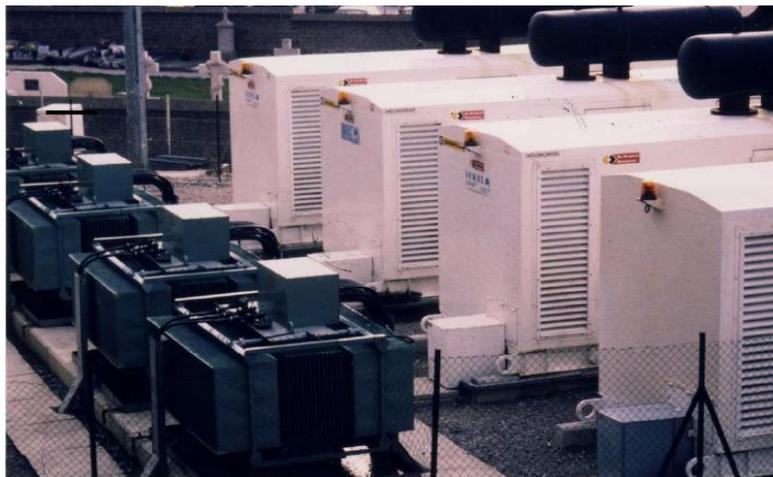
Fig. II.2.2 Groupes électrogènes de secours.
