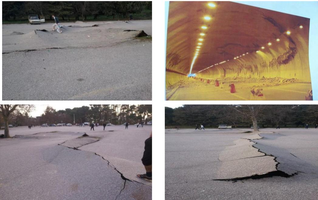
Fig. I.4.9 déformation de tunnel de jebel-Elwahech autoroute East-West Constantine
