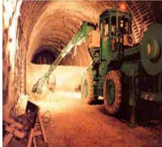
Fig. I.4.2 Creusement en demi-section
