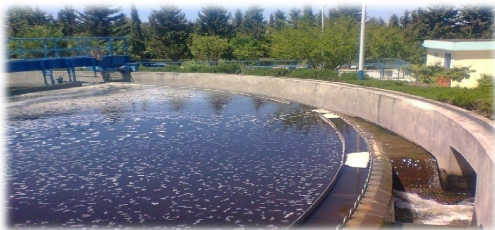
Figure N°23 : Décanteur secondaire
