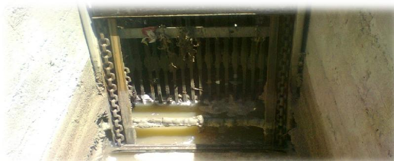
Figure N°20 : dégrillage fin.
