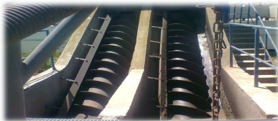
Figure N°25 : poste de recirculation des boues (pompe à vis)
