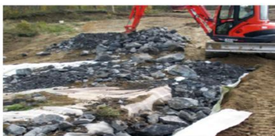
Photo 3 : Clé d'ancrage du tablier d'entrée
