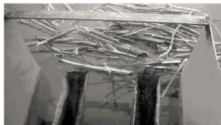
Photo 9 : Fonctionnement du P.K.Weir avec encombrement de l'entrée par des corps flottants
