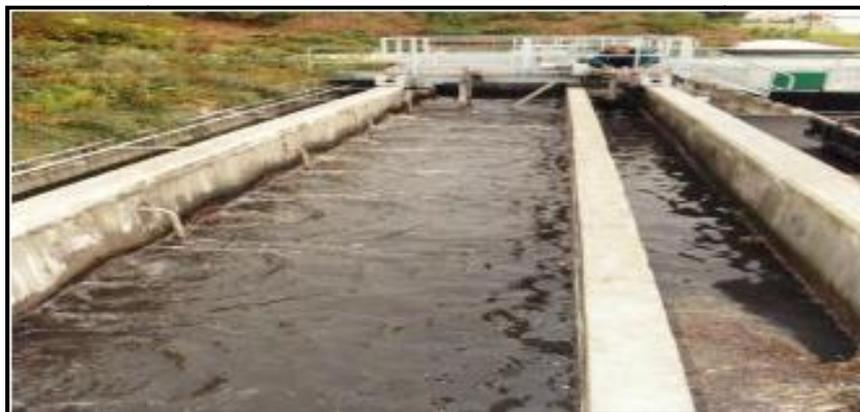
**Figure 1 :** Dessablage (Dégriment, 1972).
