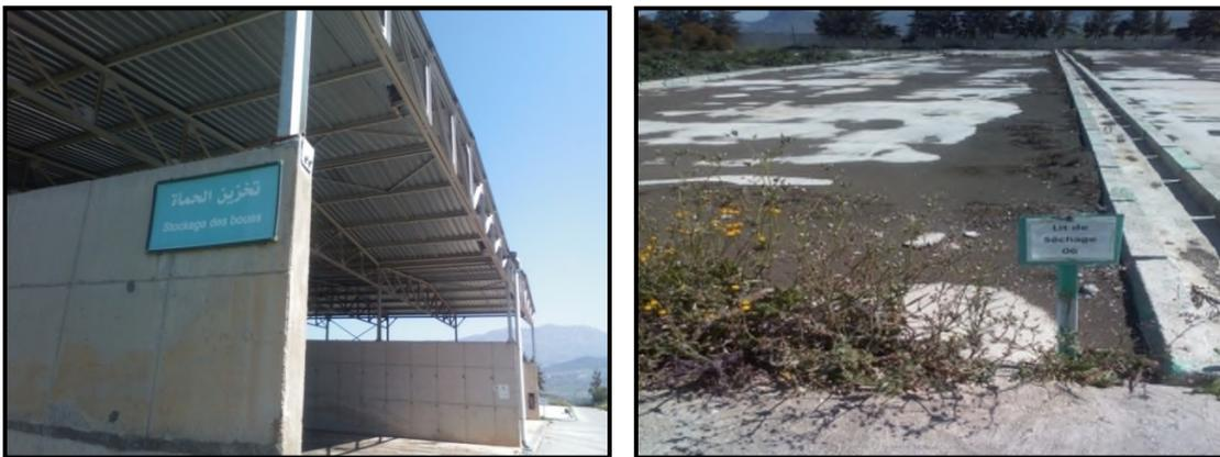
**Figure 12.** Lit de séchage et l'aire de stockage (Station Sidi Merouane).
