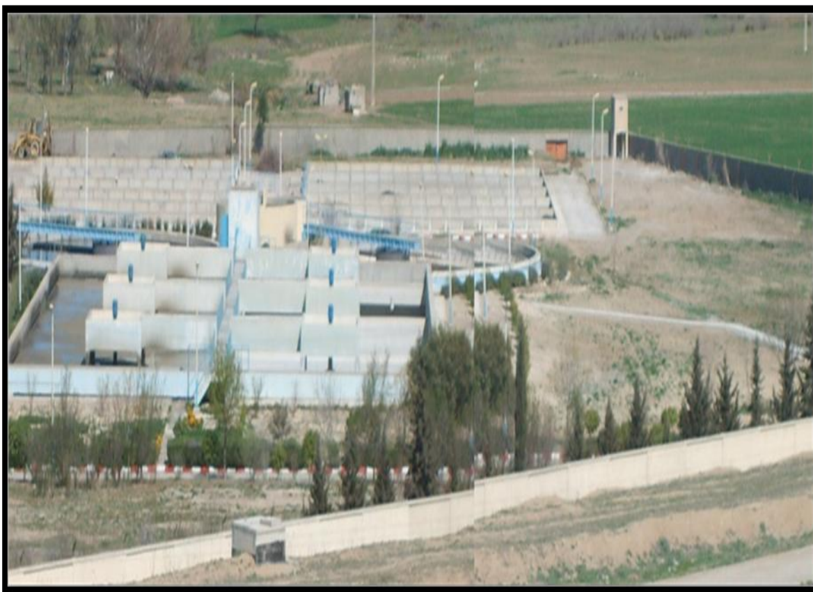
Figure n°08 : Vue de la station d'épuration des eaux usées d'Oued Athmania (STEP Oued Athmania).
