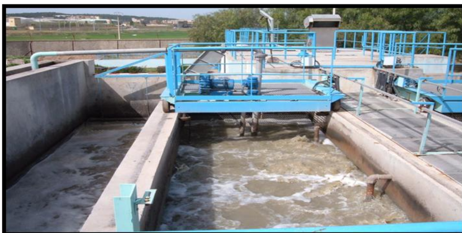
Figure n°11 : Désableur-déshuileur (STEP Oeud Athmania).
