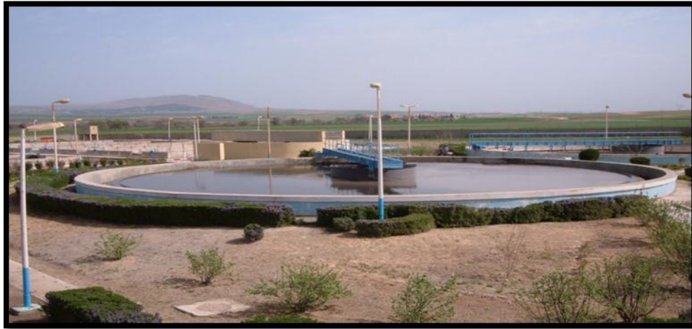
Figure n° 13 : Clarificateur (STEP Oeud Athmania).
