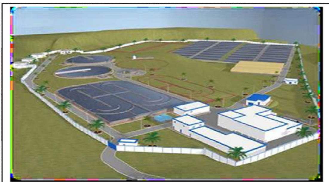
Figure04 : Vue générale de la station de Sidi Merouane.
